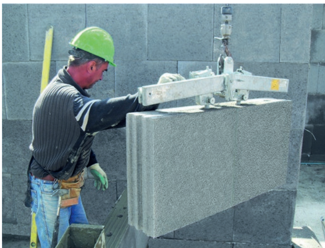
Bild 2 Einfache Handhabung: Dank moderner Versetztechnik und seiner Größe ermöglicht das KLBQUADRO-Planelement einen raschen und effizienten Wandaufbau – bei geringem Personalbedarf.
