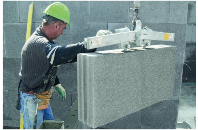
Bild 4 Die großformatigen Planelemente „KLBQUADRO“ erfüllen nicht nur alle nötigen bauphysikalischen Voraussetzungen: Dank ihrer Größe und modernen Versetztechnik ermöglichen sie zudem einen zügigen und zugleich wirtschaftlichen Mehrgeschossbau.
