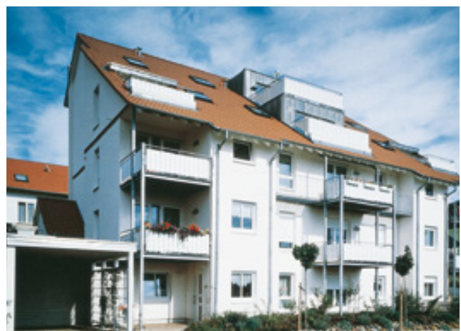
Niedrigenergiehaus in Weilmünster Architektin: Gudrun Langmack, Weilmünster
