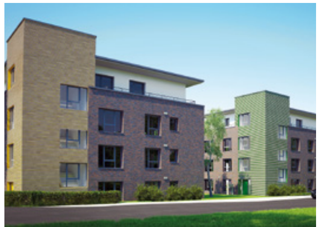
Klimaschutzsiedlung mit Passivhausstandard in Kleve Entwurf: Reppco Architekten GmbH, Kleve
