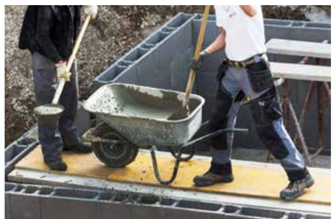
Bild 2: Einbringen des Betons
