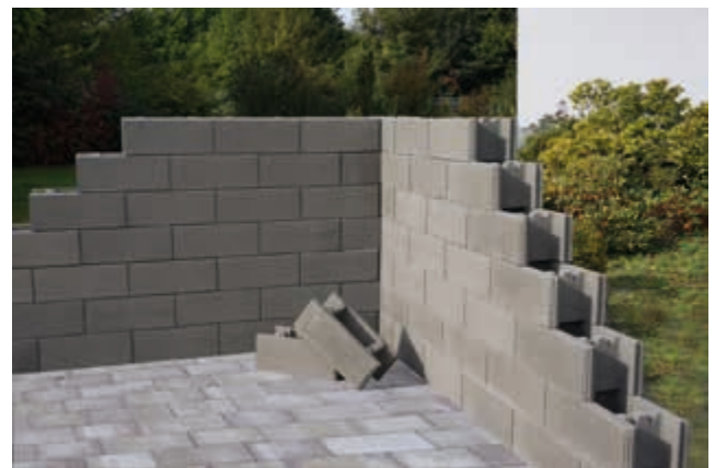
Bild 6: Wandecke aus Schalungssteinen
