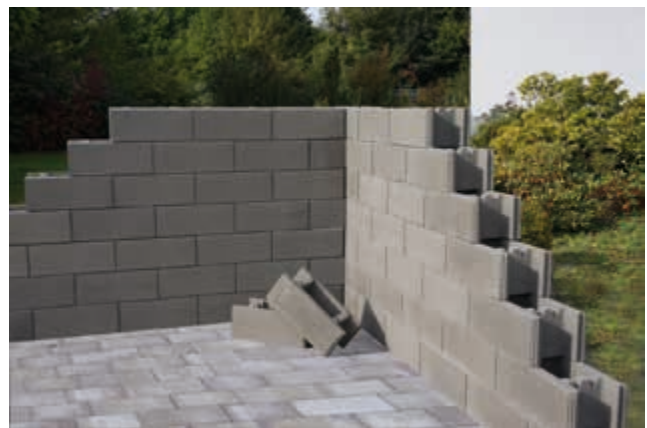
Bild 6: Wandecke aus Schalungssteinen
