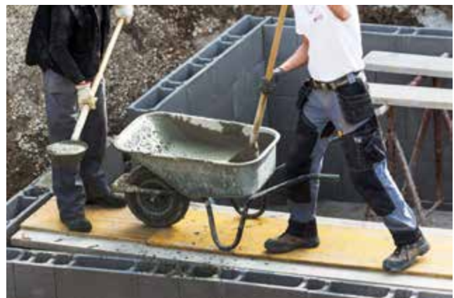
Bild 2: Einbringen des Betons
